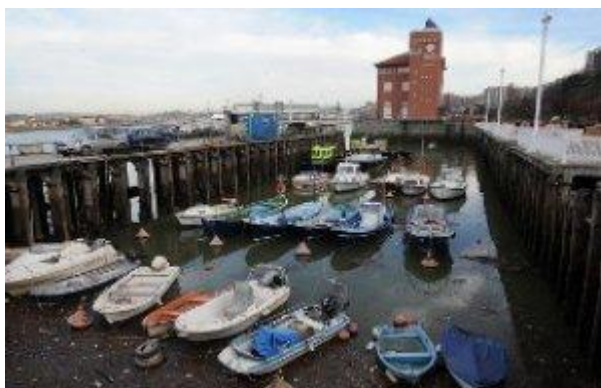
El dique, muy deteriorado, está próximo al Museo Rialia. :: F. GÓMEZ
