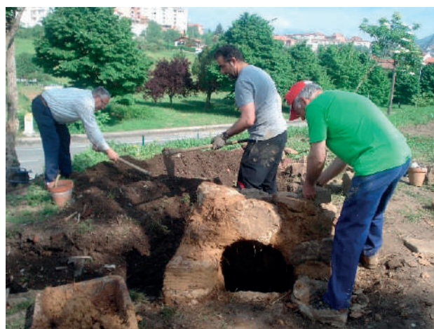
Figura 107. "Taller de arqueología experimental del hierro" en el Museo de la Minería del País Vasco. Izda. Construcción del espacio del taller (en primer plano el agujero de carga y descarga del horno sobre la "rampa" interior). Dcha. Horno de reducción. Abajo se ve el agujero practicado en el fondo del crisol y a la izquierda la forma rectangular donde embocarí la tobera y el fuelle.
